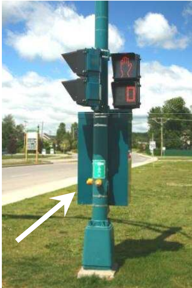
Montage sur fût
