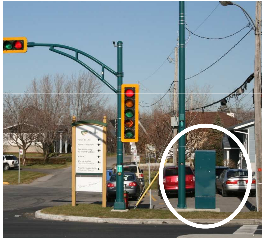
Montage sur base de béton
