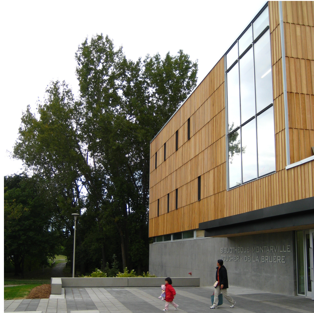
↪ entrée principale au sud
